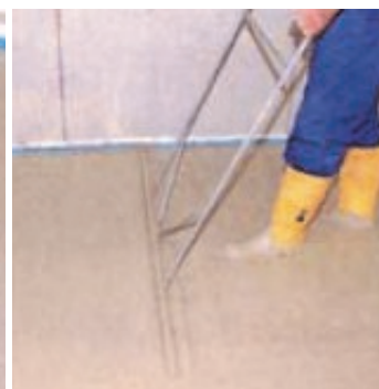
Obr.4 Vibrování potěru
