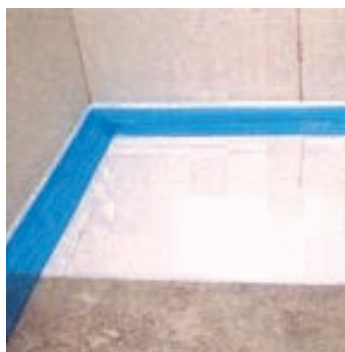
Obr.2 Položení izolačních desek a separační vrstvy.
