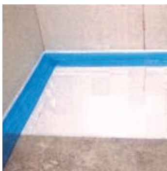
Obr.1 Osazení okrajových pásků, položení izolačních desek a separační vrstvy.
