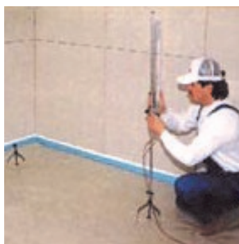
Obr.2 Osazení nivelačních trojnožek.
