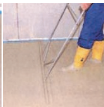
Obr.4 Vibrování potěru.
