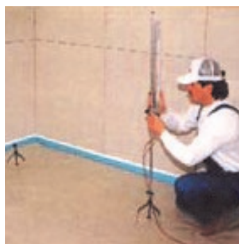
Obr.2 Osazení nivelačních trojnožek.
