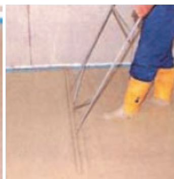
Obr.4 Vibrování potěru.
