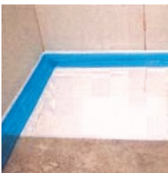
Obr.1 Osazení okrajových pásků, položení izolačních desek a separační vrstvy.
