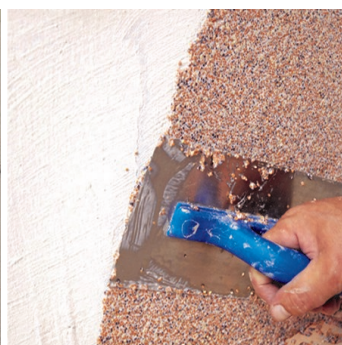
Obr.3 Nanášení mozaikové omítky. Obr.4 Hotová omítka.
