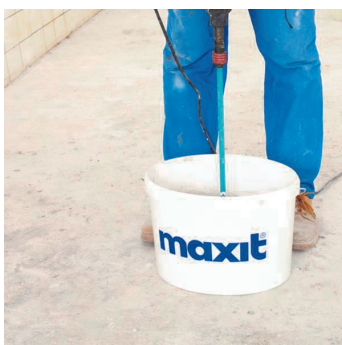
Obr.1 Podklad připravit předepsaným způsobem. Obr.2 Promíchání omítky.
